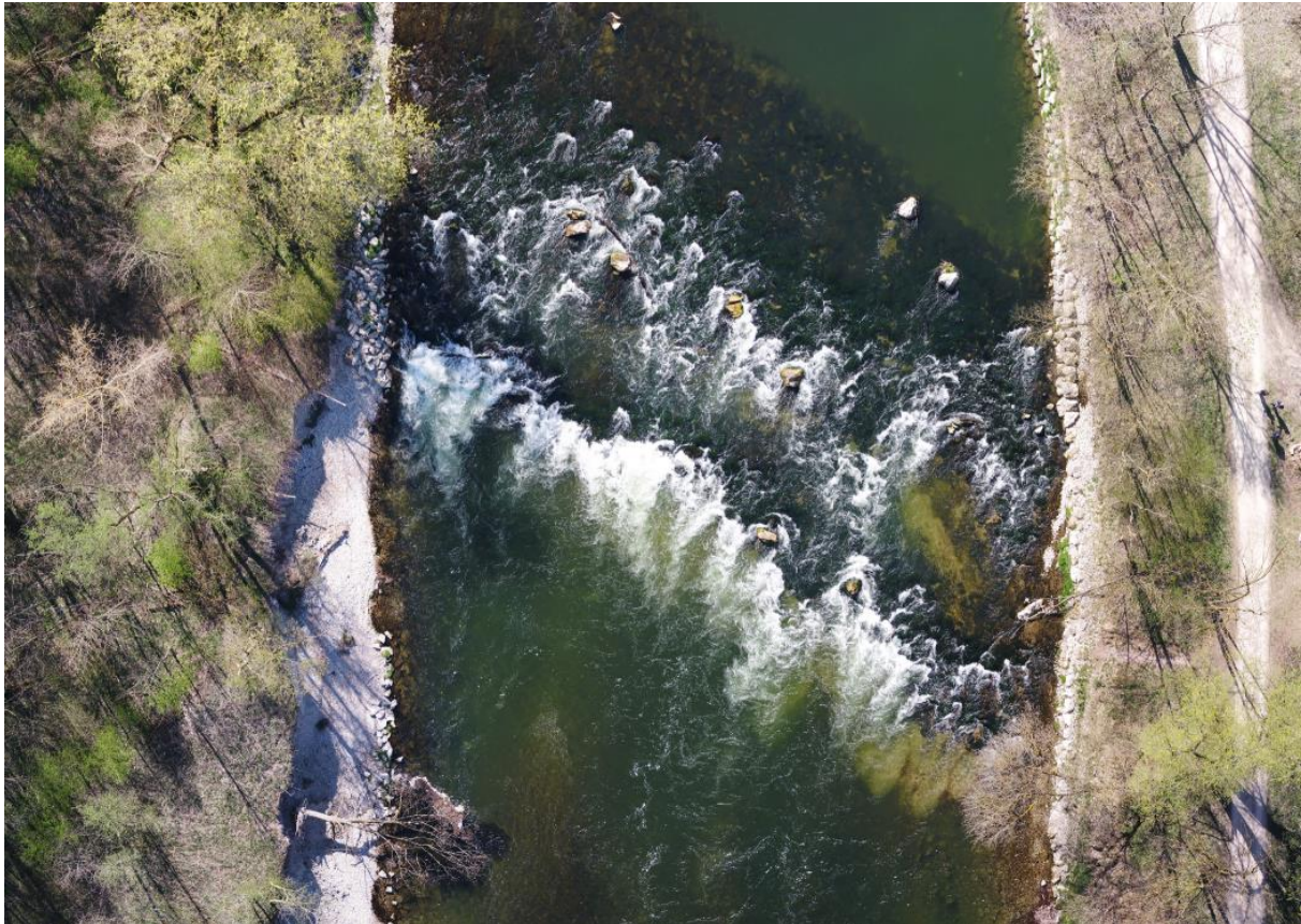
Sohlgleite beim Eggertshof
