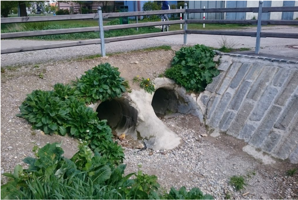
Engstelle im vorhandenen Deichhintergraben: Im Hochwasserfall kann ein zu kleiner Durchlass ein Überlaufen verursachen. (Bild: WWA München)
