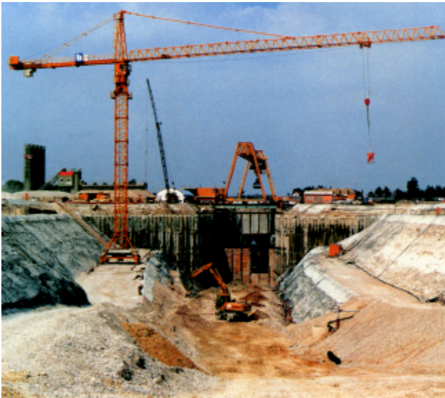
Baugrube (rechts im Bild ein Wasserhaltungsbrunnen)
