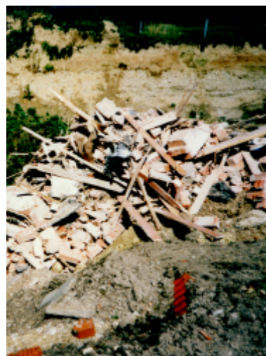
So sollte sortierter Bauschutt nicht aussehen
