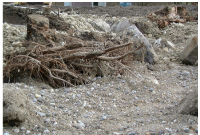
Umgehungsgerinne im Bau
