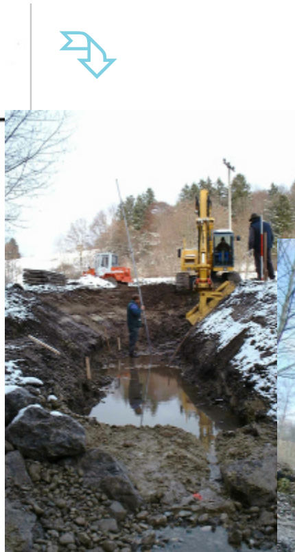
Rohplanie mit Grundwasserzutritt
