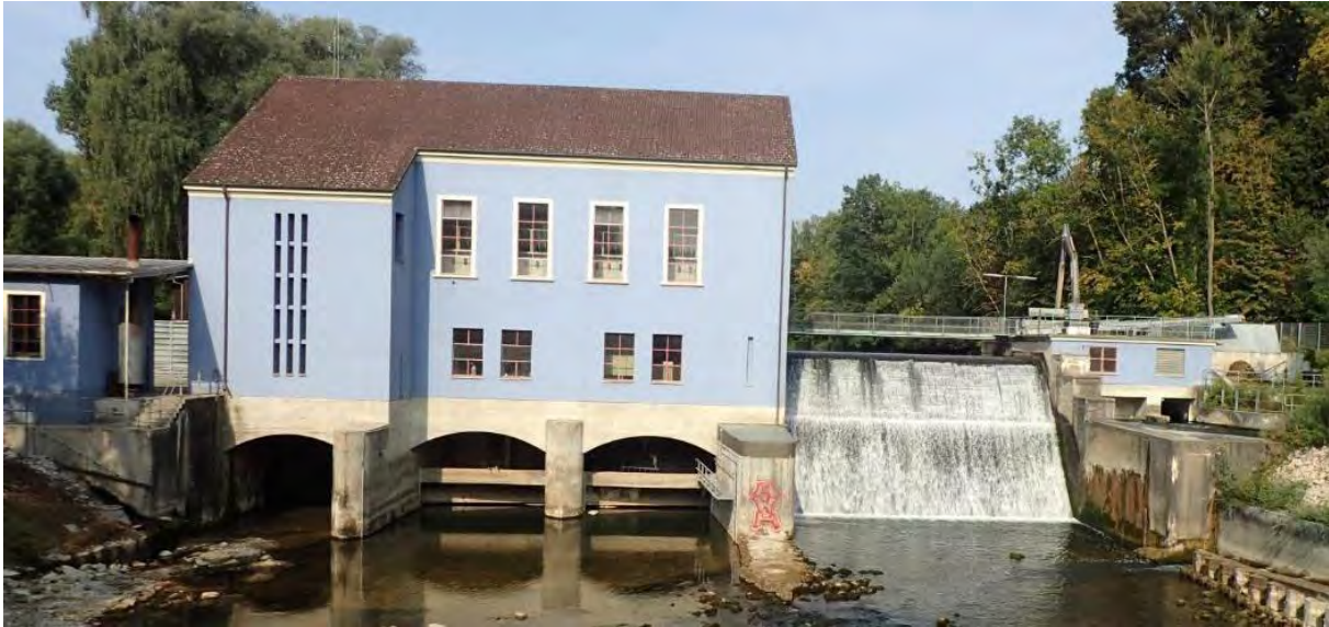
Abbildung 8: WKA Dachau (Ansicht von Unterwasser)
