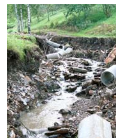
▲ Hochwasser hat zu einer schlagartigen Erosion geführt. Ein Gehölzsaum hätte dem entgegengewirkt.
