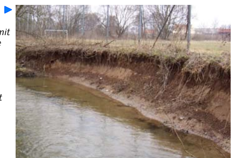
Die Sohlage immer zuerst stabilisieren!
