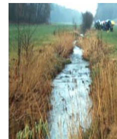
▲ Nachher: Naturnahe Sohlwellen, Uferaufweitungen und Bewuchs bremsen das Hochwasser.
